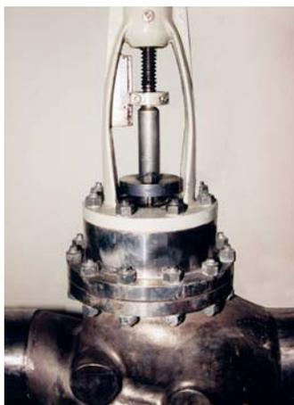
Wie Untersuchungen belegen, stammt ein großer Anteil der Emissionen von Kraftwerken, chemischen Anlagen o.ä. aus Spindelabdichtungen von Armaturen. Ein erhöhtes Umweltbewusstsein verlangt die Minimierung dieser Emissionen, wobei über eine Optimierung der Funktion von Armaturen sowohl Mediumverlust als auch Instandhaltungskosten und Stillstandzeiten maßgeblich reduziert werden können. Damit erhöht sich auch die Wirtschaftlichkeit.
